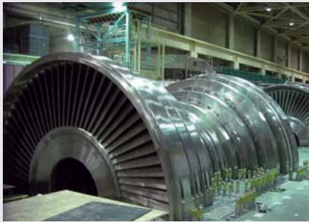
◀ 高性能タービンの組立状況 Assembly work for high-efficiency turbine
