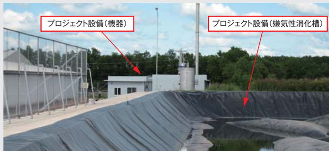
▲ 建設中のプロジェクト設備 Facilities under construction
