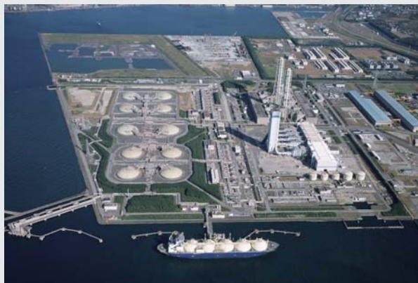
▲ 東京電力(株)富津火力発電所 Overview of Futtsu Thermal Power Station of The Tokyo Electric Power Co., Inc.
